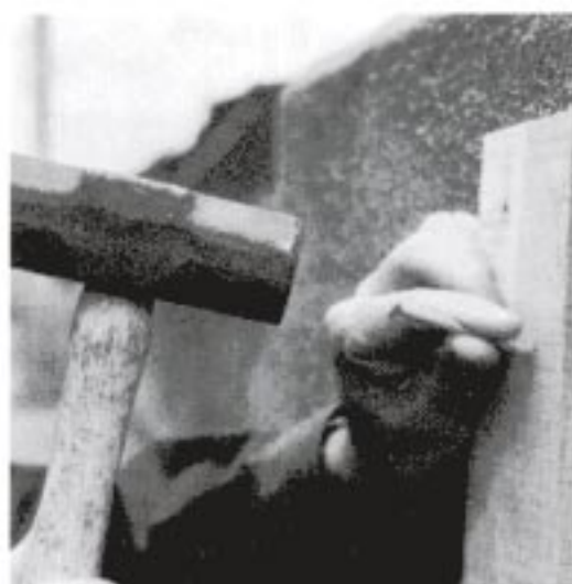
木材の取付け
