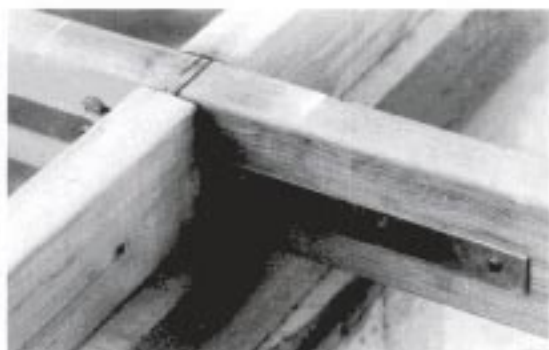
▶なき金物との緊結 土台と根太の緊結及び根太つ
