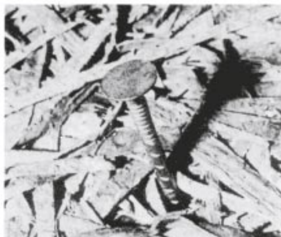
木毛セメント板の取付
